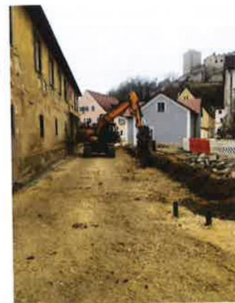
Das Gebäude, das die Engstelle bildet, wird künftig einen Schutzstreifen erhalten, um so Schäden an der Fassade zu vermeiden. Die Fahrbahn selbst wird künftig eine durchgängige Breite von ca. 4,5 m (incl. 0,5 m Schutzstreifen) im Bereich der Engstelle erhalten, diese betrug bisher nur ca. 3,1 m.
