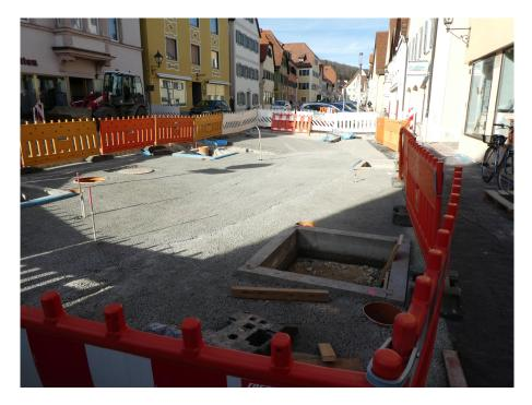
Seit heute wird das Traufpflaster im Bereich Engeler Ë Gampl hergestellt. Als nächstes stehen die Kabelverlegearbeiten in der Stöbergasse und die Erdarbeiten im Bereich des Juz Ë Platz an.
