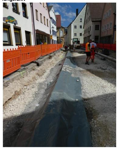
Im Bereich der Engstelle wurde die erste Lage der Frostschutzschicht eingebaut. Der Zugang zum Notar erfolgt über einen seitlichen Schotterstreifen.
