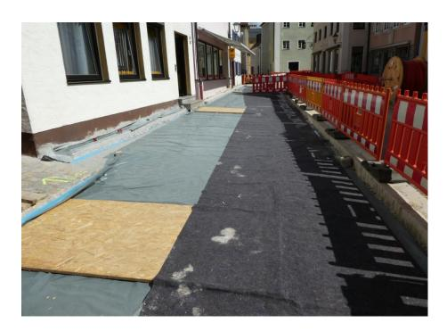
Anfang nächster Woche wird das Traufpflaster im östlichen Bereich hergestellt und seitens der Telekom werden Spleissarbeiten durchgeführt. Bis zum nächsten Wochenende sollte in diesem Bereich der Drainbeton eingebaut sein.
